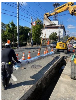
(水道管の敷設替)
