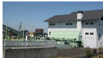
(黒瀬ポンプ場)
